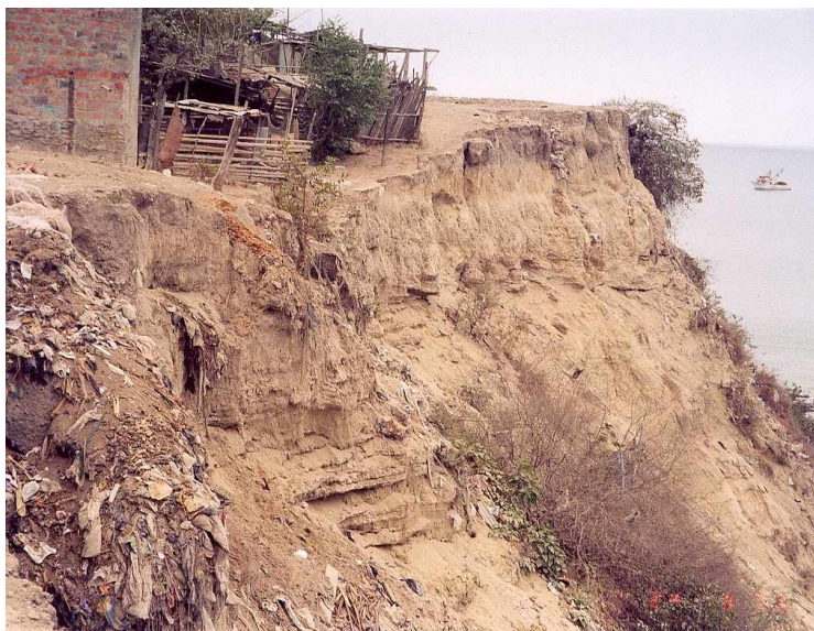
Foto3. Asentamientos humanos sobre acantilados, barrio “Galo Plaza” Jaramijó – Manabí . [Foto M. Cruz, Agosto 2004]
